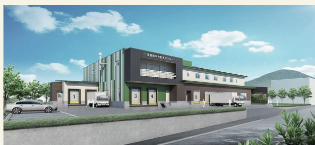
新たに建設された学校給食センター
